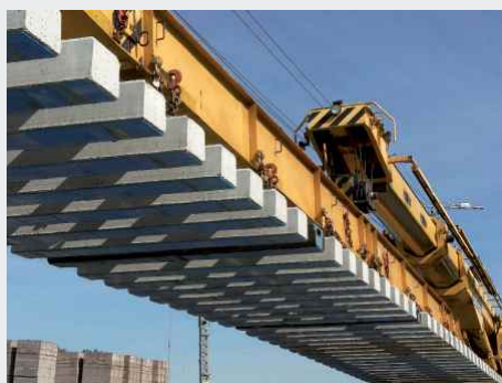
弹性轨枕铺设
