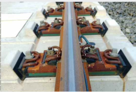
Zwischenplatten in einer Brückenübergangs-Konstruktion im Netz der DB
