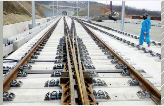
Elastische Stützpunktlagerung in einer Hochgeschwindigkeitsweiche, Südkorea
