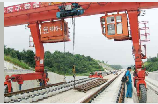
Bau der Festen Fahrbahn in China
