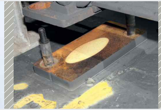
Ausbau einer Zwischenplatte in der Londoner U-Bahn
