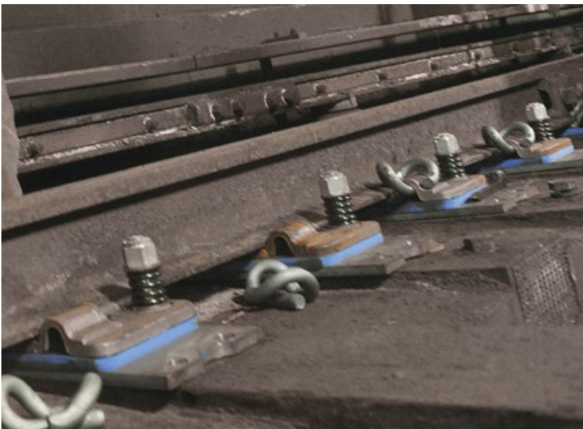
Einbau von Zwischenplatten in der New Yorker U-Bahn – seit Jahrzehnten im Einsatz
