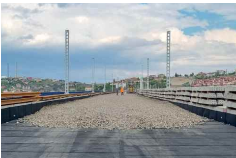
Schwellensohlen schonen den Schotter, verbessern die Gleislagestabilität und verlängern die Lebensdauer des Oberbaus.
