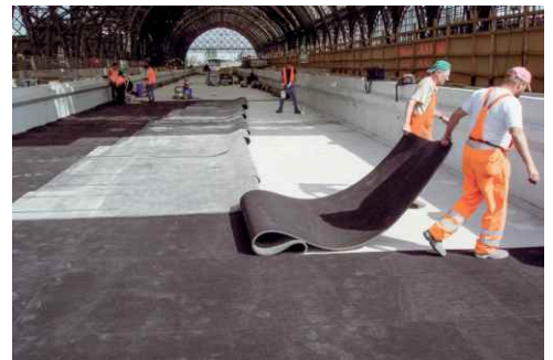
Die einfach und schnell zu verlegenden Unterschottermatten und Seitenmatten verringern nachhaltig den Instandhaltungsaufwand auf der neuen Hochgeschwindigkeitsstrecke.
