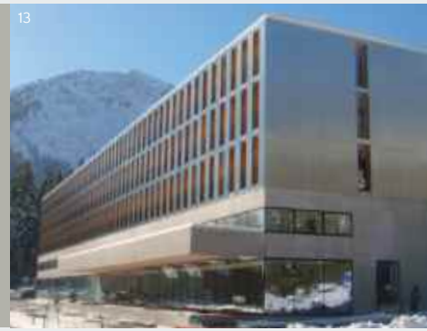
Alpenhotel Ammerwald, BMW Group en construction modulaire
