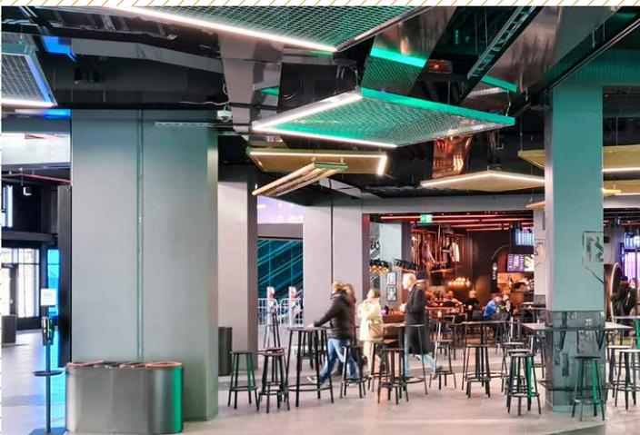
Herausfordernde Auslegung der Schwingungsisolierung: Das Hotel ist über voneinander entkoppelte Doppelstützen – links im Bild – mit der Arena verbunden. Auf dem linken Stützenteil fußt das Hotel, auf dem rechten die Arena.
