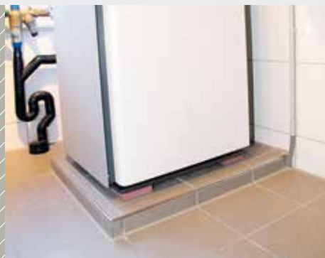
Punktförmige Sylomer® Lager für eine Wärmepumpe
