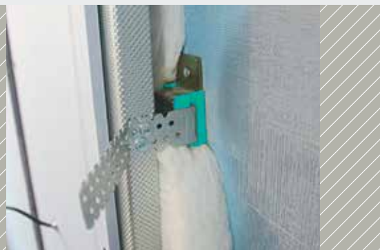
Mit Sylomer® entkoppelte Vorsatzschalen für hohe Dämmwirkung
