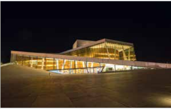
Schallschutzlösung von Getzner im Opernhaus Oslo
