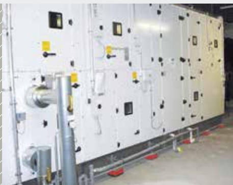
Raumluftechnische Anlage (RLT) gelagert auf Isotop® SE Elementen.
