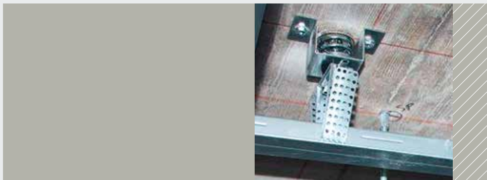
Federabhängler für tieffrequent abgestimmte Unterdecken
