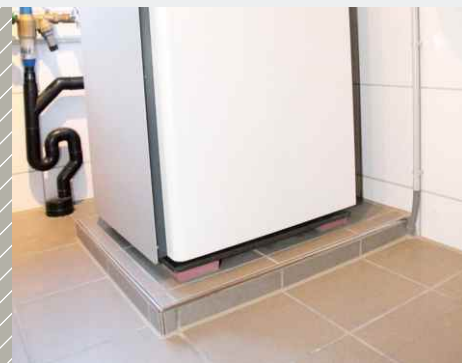
Punktförmige Sylomer® Lager für eine Wärmepumpe
