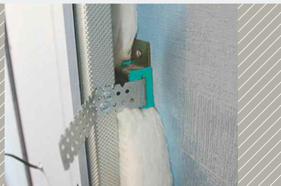
Mit Sylomer® entkoppelte Vorsatzschalen für hohe Dämmwirkung
