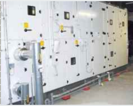
Raumlufttechnische Anlage (RLT) gelagert auf Isotop® SE Elementen.
