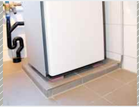
Punktförmige Sylomer® Lager für eine Wärmepumpe
