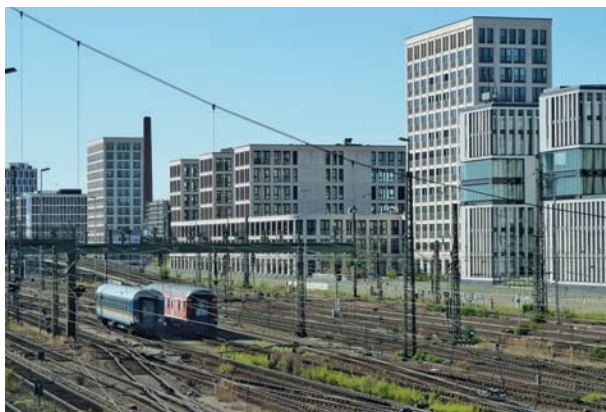
Bild 8. Bauwerkskomplex am Arnulfpark, direkt an der S-Bahn-Stammstrecke
