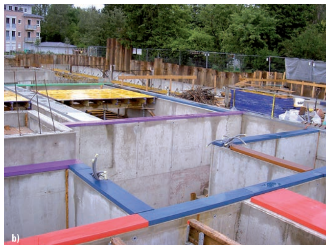
Bild 6 Lagerungsvarianten: a) vollflächig (links), b) Trennung unter der Kellerdecke (rechts) Bedding variants: a) continuous (left-hand side), b) isolation below the basement ceiling (right-hand side)
