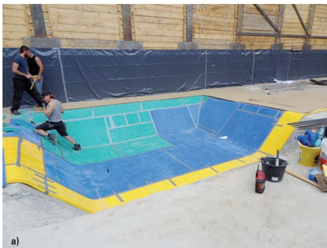
Bild 6 Lagerungsvarianten: a) vollflächig (links), b) Trennung unter der Kellerdecke (rechts) Bedding variants: a) continuous (left-hand side), b) isolation below the basement ceiling (right-hand side)
