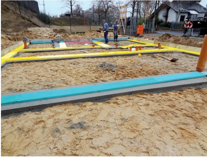
Bild 9 Einbau der Sylodyn®-Lager auf Streifenfundamenten und unter Filigranplatten / Haus Schröder Installation of the Sylodyn®-bearings on strip footings and below permanent shutterings / Schröder house
