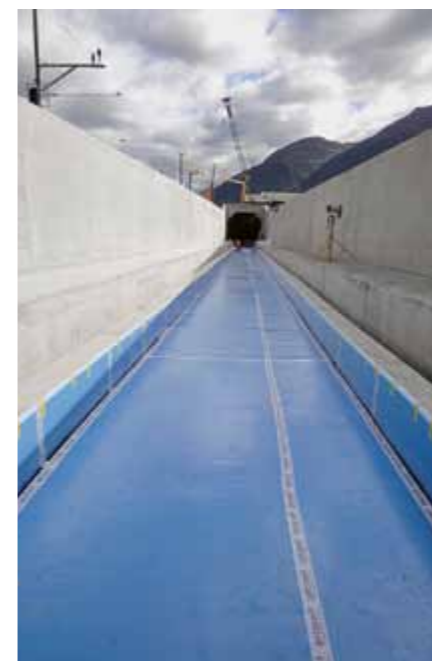
Bild 1: Die Tieferlegung erfolgte über eine ca. 300 m lange, im Grundwasser liegende Betonwanne
