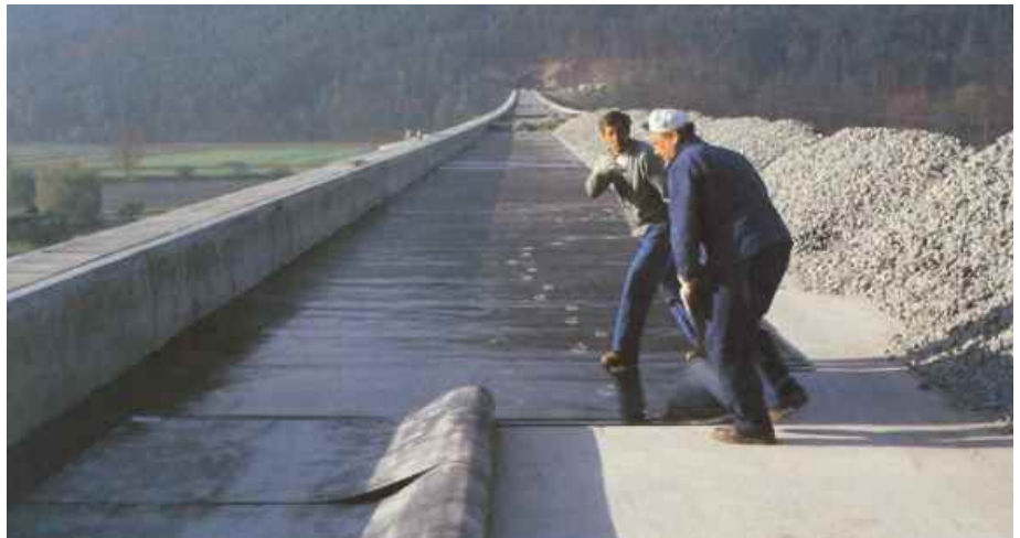
Abb. 2: Einbau der USM D 220 auf der Bartelsgrabenbrücke 1987
