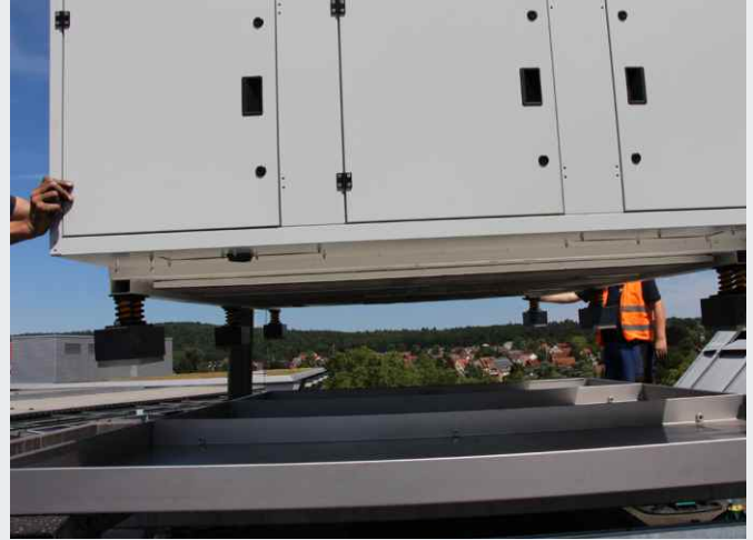
Geräteaufstellung mit vormontierten Isotop® DT
