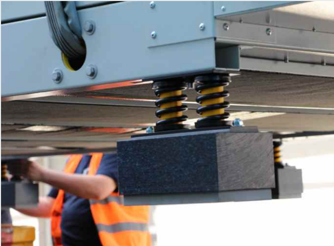
Isotop® DT vormontiert auf Geräterahmen
