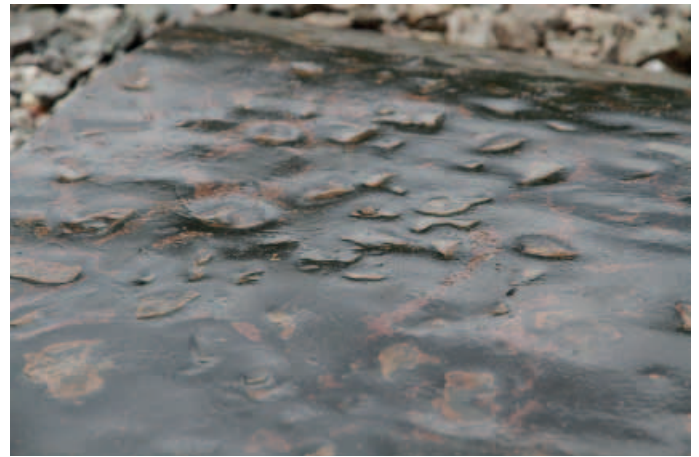
Abb. 4: Abdrücke der Schottersteine auf der Lastverteilungsschicht
