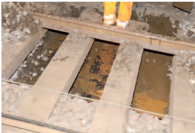
Abb. 1 und 2: freigelegte Unterschottermatte, Wasser auf den Matten deutlich erkennbar
