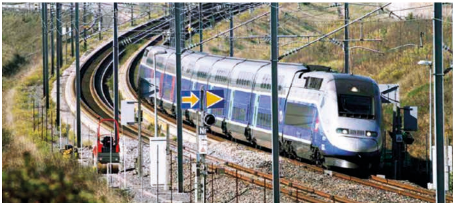
BILD 1: SNCF Réseau untersucht Übergangsprobleme von Fester Fahrbahn auf Schotteroberbau auf der Hochgeschwindigkeitsstrecke LGV Est (Foto: Regis Chessum)
