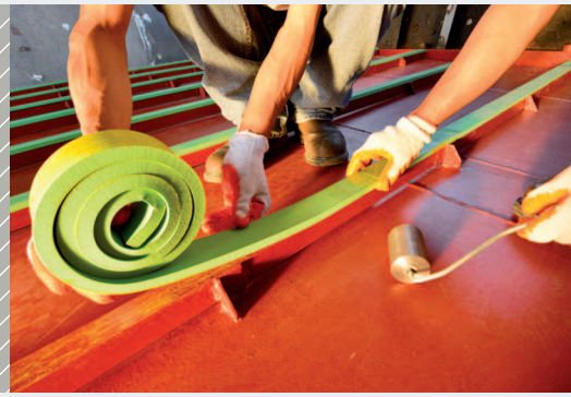
Anbringen der Vibrationslagerung mittels Sylomerstreifen
