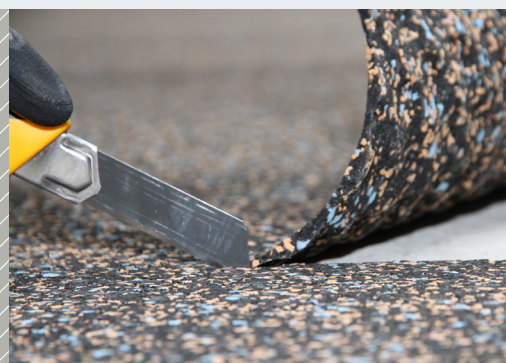
Maneggevolezza e rapidità di posa
