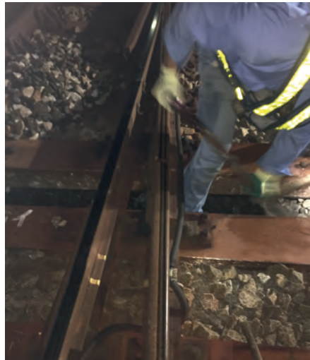
Abb. 3: Ausbau der Schwellensohlen in einer Nachtschicht
