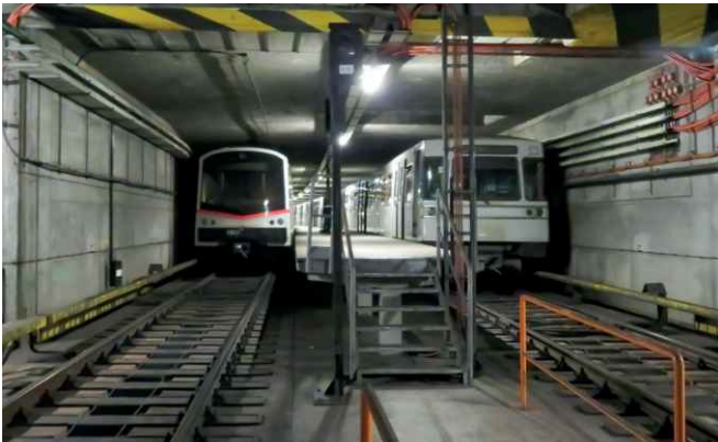
Der neuere Zugtyp V (links) verursacht im Tunnel stärkere Emissionen als der ältere Zugtyp U11 (rechts).
