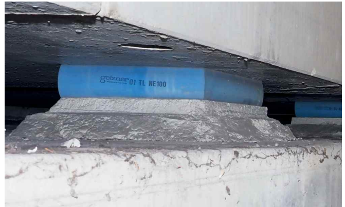
Ungestörter Musikgenuss: Die Sylodyn®-Punktlager dämmen die von den Zugvorbeifahrten hervorgerufenen Immissionen
