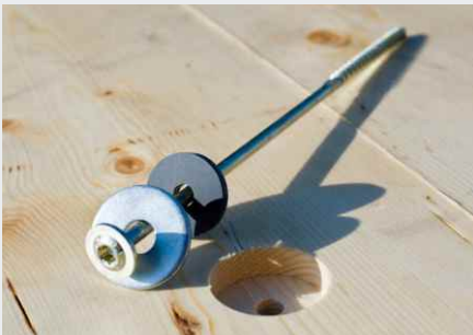
Fig. 5 : Utilisation de la rondelle élastique
