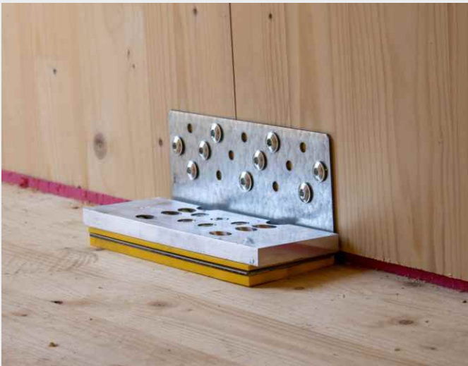
Fig. 3 : Connecteur élastique à angle GEPI Connect 240
