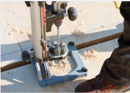
Abb. 4: Vorbohrung
