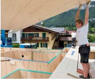
7 Versetzen der Holz-Elemente
