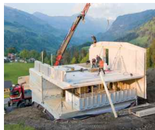
11 Vorgang bei allen weiteren ausständigen Ebenen wiederholen.
