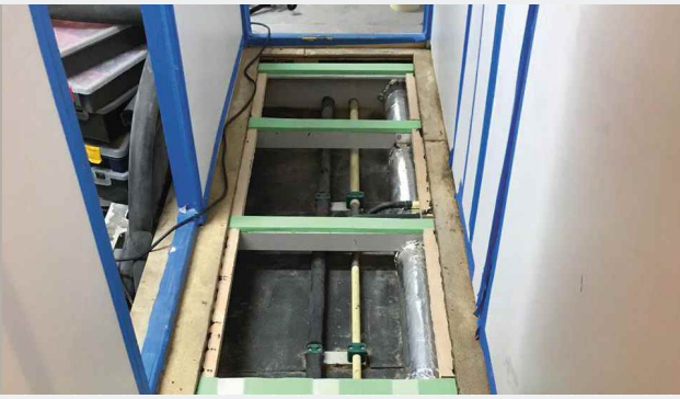
Lagerung des Schiffbodens mittels Sylomer®-Streifen
