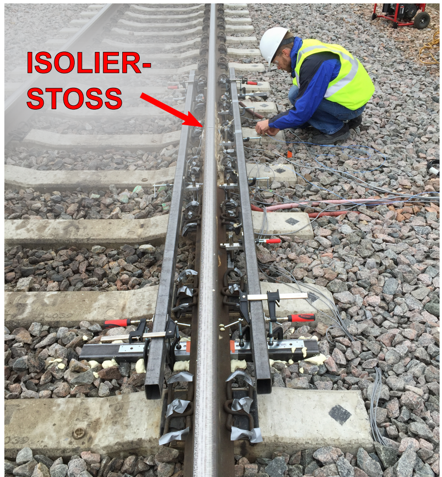
Bild 10: Messsetup im Gleis
