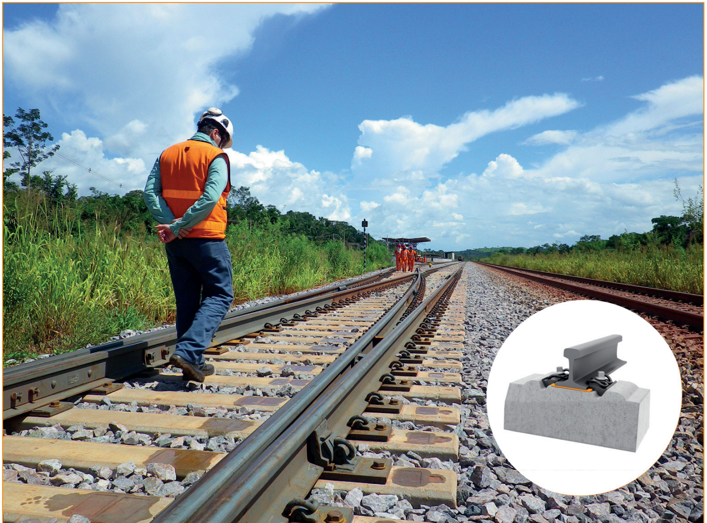
Abb. 12: Getzner Zwischenlagen aus Polyurethan im Eisenbahnoberbau
