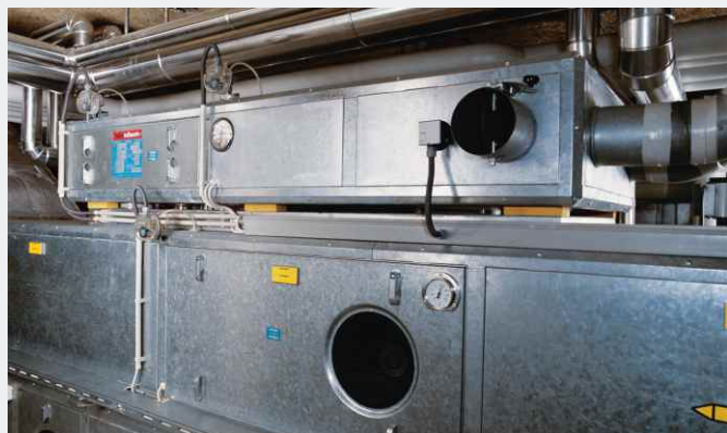
Modules découplés d'un appareil de ventilation
