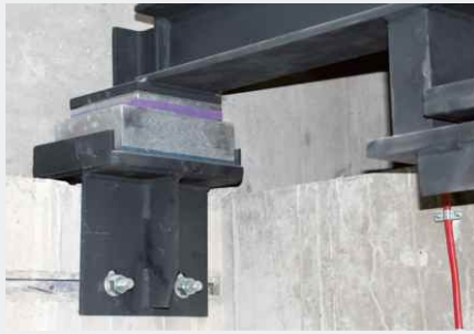
Isolation d'un ascenseur avec porte-câble dans la tête de cage
