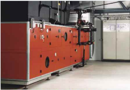
Installation VMC placée en sous-sol
