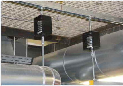
Tuyauteries découplées avec SD/Z
