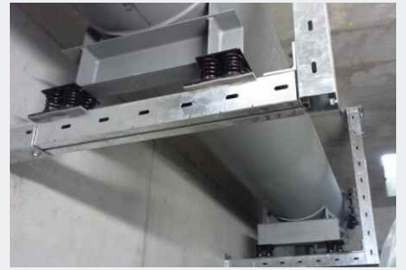
Isolation de conduits d'échappement
