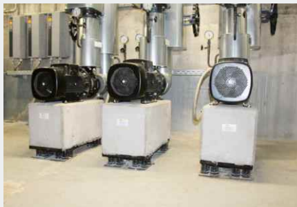
Isolation de pompes avec masse supplémentaire
