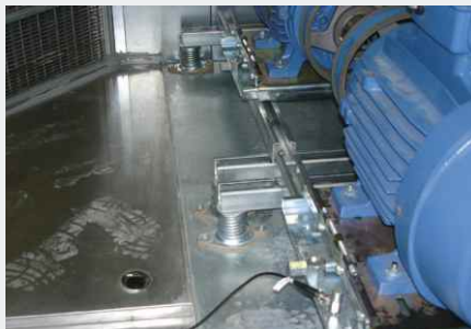
Isolation de ventilateurs à entraînement par courroie
