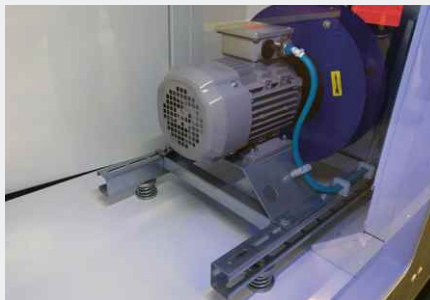
Ventilateur axial dans une installation VMC
