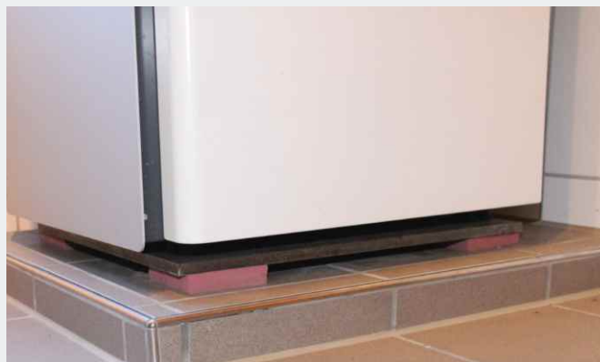
Découplage de l'intérieur d'une pompe à chaleur
