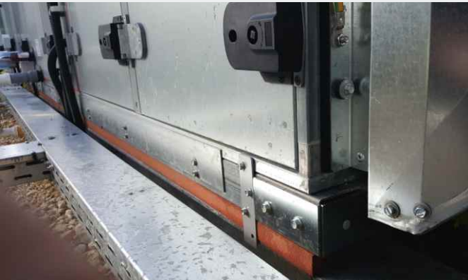
Bandes isolantes pour un appareil de ventilation (VMC)
