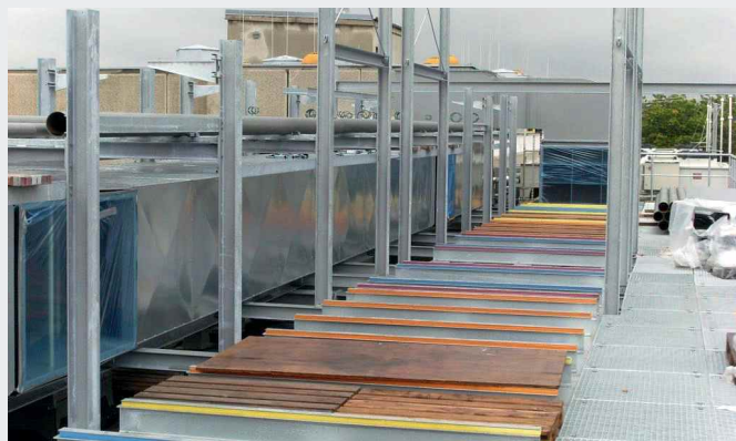
Bandes isolantes préparées pour un appareil de ventilation sur toit
