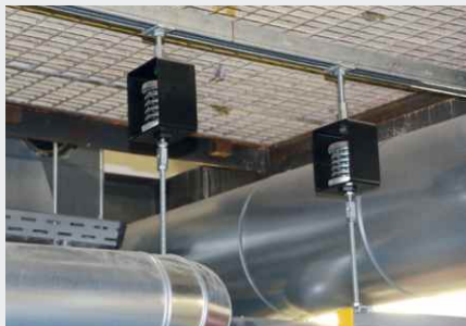
Tuyauteries découplées avec SD/Z
