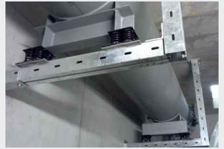
Isolation de conduits d'échappement
