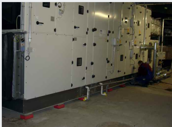
Mise en place d'un appareil VMC sur Isotop® SE
