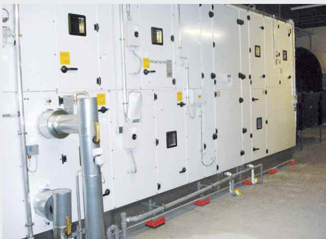
Appareil de ventilation posé sur Isotop® SE
