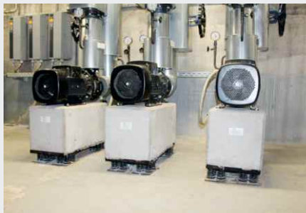
Isolation de pompes avec masse supplémentaire
