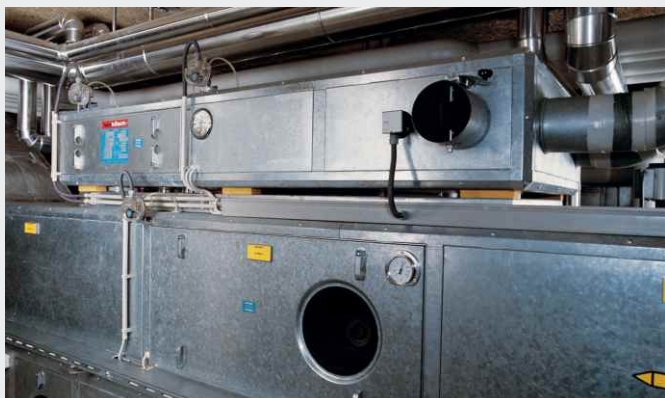
Modules découplés d'un appareil de ventilation
