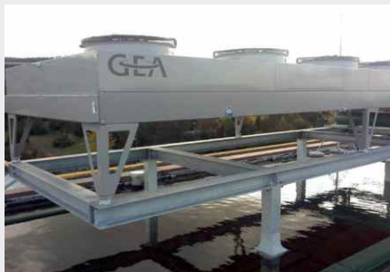
Refroidisseur avec Isotop® DZE pour une protection contre les vents violents
