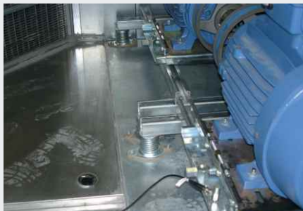
Isolation de ventilateurs à entraînement par courroie
