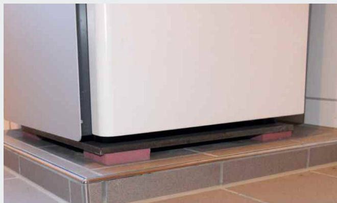
Découplage de l'intérieur d'une pompe à chaleur
