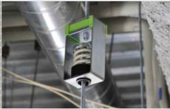
AMC Deckenabhängiger mit Sylomer® Lager
