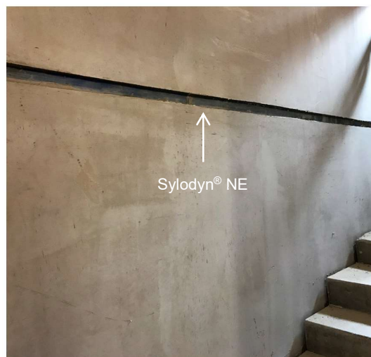
Fig. 2: Appui linéaire sur voile, dans la cage d'escalier (Source: Getzner Werkstoffe)
