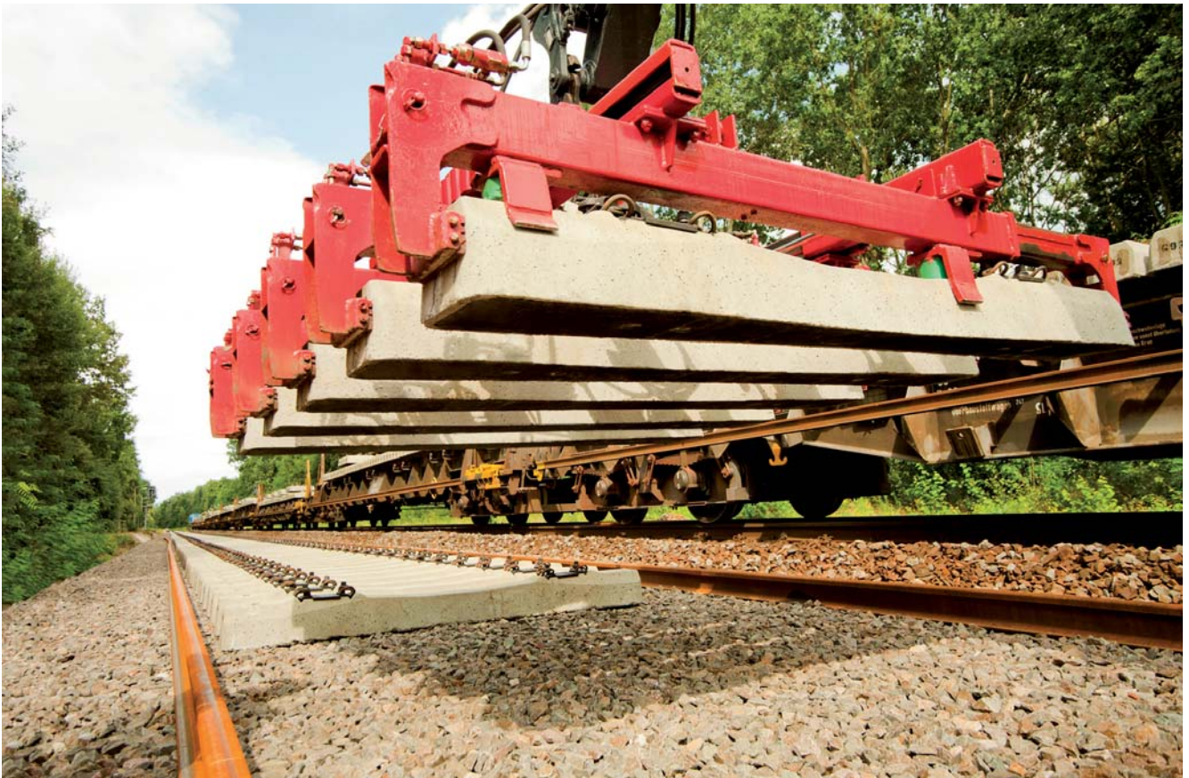
3. ábra Alul Sylomer® USP-vel ellátott vasbetonaljak telepítése
