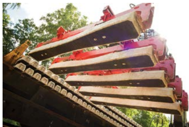
Slika 1. Poliuretanski podlošci kolosiječnih pragova tipa SLS1308G izrađeni od Sylomera®
