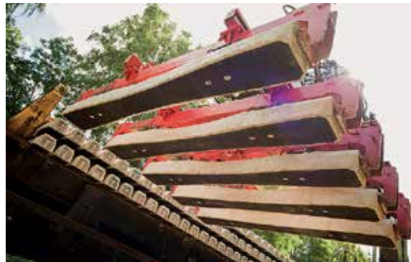
Bild 1: Zum Einsatz kommen Polyurethan-Schwellensolehlen aus Sylomer® vom Typ SLS1308G
