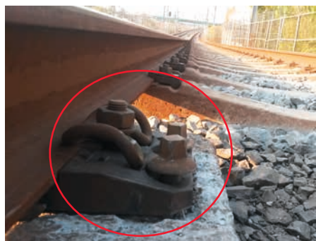
BILD 7: Beschädigungen an der Feste Fahrbahn mit herausgezogenen Befestigungsschrauben (links), Lösung durch Einbau plastischer Ausgleichsplatten und elastischer Zwischenlagen (rechts)
