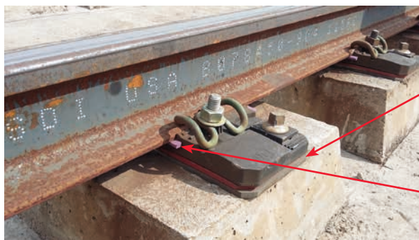
BILD 7: Beschädigungen an der Feste Fahrbahn mit herausgezogenen Befestigungsschrauben (links), Lösung durch Einbau plastischer Ausgleichsplatten und elastischer Zwischenlagen (rechts)
