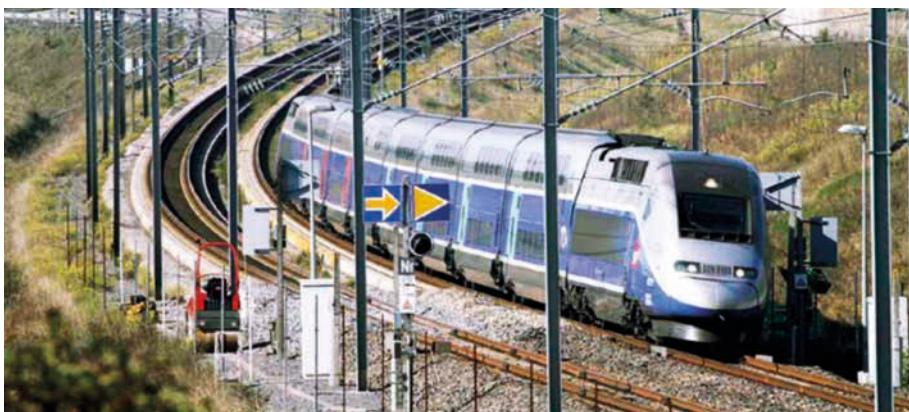
BILD 1: SNCF Réseau untersucht Übergangsprobleme von Fester Fahrbahn auf Schotteroberbau auf der Hochgeschwindigkeitsstrecke LGV Est (Foto: Regis Chessum)
