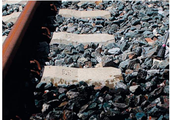
BILD 5: Beischienen am Übergang (links), Schotterverklebung zur Schotterstabilisierung (rechts)
