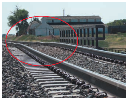
BILD 4: Verschleißerscheinungen im Übergangsbereich: Schotterabrieb mit weißen Stellen (links), Gleissetzungen im Schotter (Mitte) und Riffelbildung (rechts)
