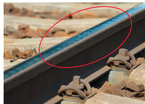
BILD 4: Verschleißerscheinungen im Übergangsbereich: Schotterabrieb mit weißen Stellen (links), Gleissetzungen im Schotter (Mitte) und Riffelbildung (rechts)
