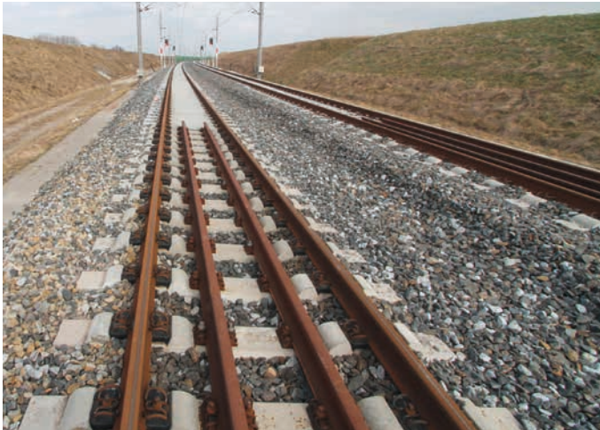
BILD 5: Beischienen am Übergang (links), Schotterverklebung zur Schotterstabilisierung (rechts)
