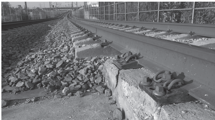
図-2 バラスト軌道からスラブ軌道へ変化する軌道構造境界部で生じた軌道の損傷
