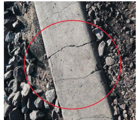
**BILD 8:** Beispiele für typische Probleme in internationalen Schwerlaststrecken: Schotterzerstörung unter Betonschwellen (links), Spannklemmenbrüche (Mitte) und Schwellenrisse (rechts) resultieren meist aus zu hohen dynamischen Belastungen
