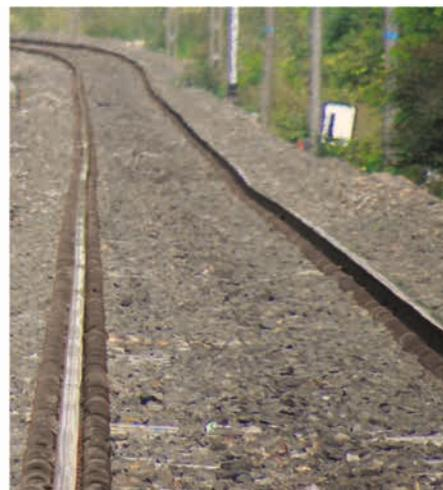
**BILD 15:** Die unterschiedliche Qualität vergleichbarer Gleisabschnitte ist offensichtlich, mit Schwellensohlen (links), ohne Schwellensohlen (rechts)
