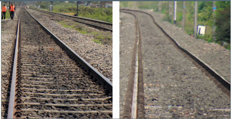
BILD 9: Die unterschiedliche Qualität vergleichbarer Gleisabschnitte ist offensichtlich, mit Schwellenbesohlungen (links), ohne Schwellenbesohlungen (rechts)
