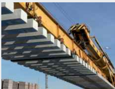
Tren para el tendido de vía con suelas bajo traviesa
