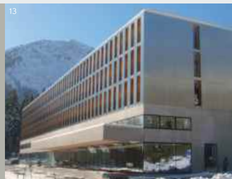
Гостиница Bregenzerwald Alpenhotel Ammerwald, BMW Group модульной конструкции
