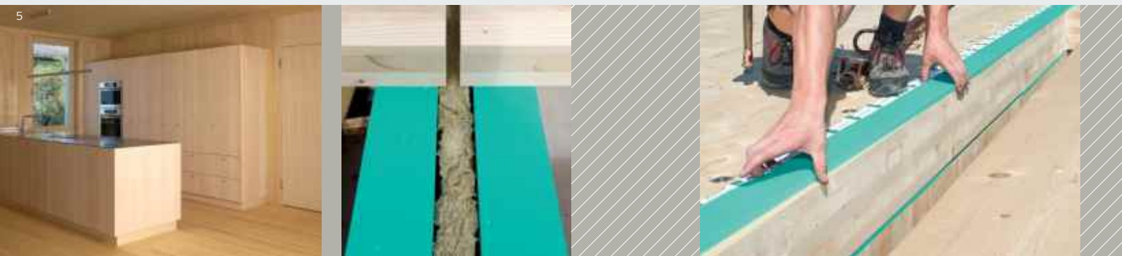
Упругая опора стены и перекрытия
