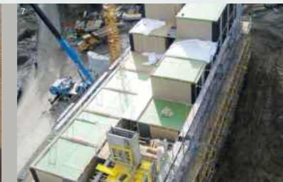
Деревянные модули с опорами из материала Sylomer.
