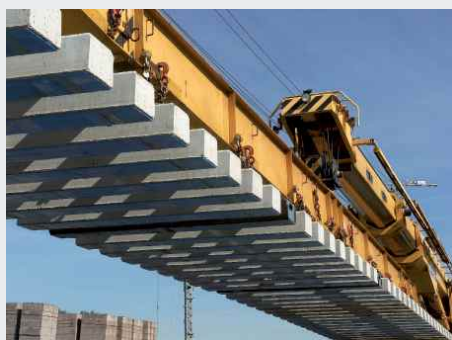
Maszyny budowlane z materiałami wibroizolacyjnymi
