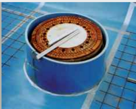
Izolacja studzienki kanalizacyjnej w systemie masy odsprężynowanej
