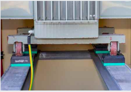
Schwingungsentkoppelte Lagerung eines Verteiltransformators
