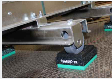
Schwingungsentkoppelte Lagerung eines Verteiltransformators
