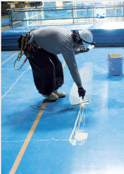
シロマー (Sylomer®) 2層目敷設時の接着剤塗布 ノロ止めのポリフィルム敷設
