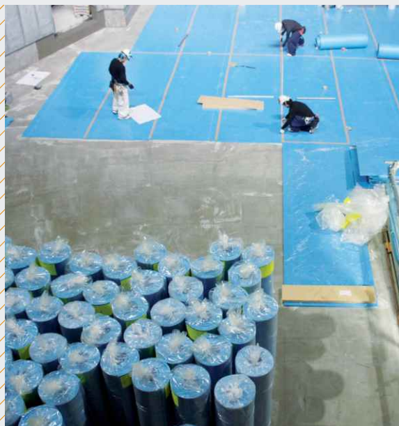
シロマー (Sylomer®) 1 層目の敷設
