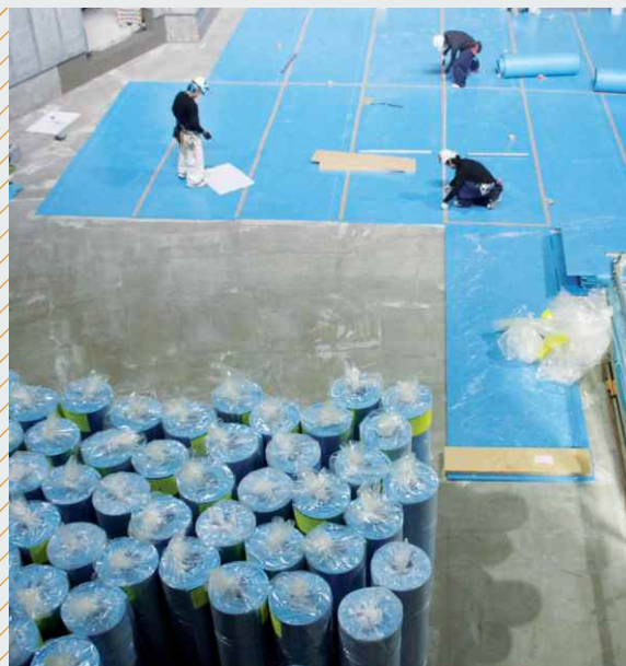
シロマー (Sylomer®) 1 層目の敷設
