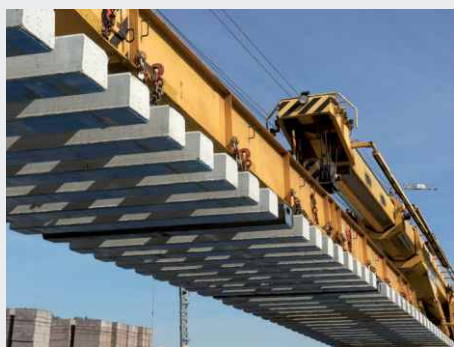
Treno di montaggio con materassini sugli scambi
