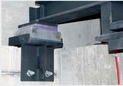
Lagerung einer Aufzugsanlage mit Seilträger im Schachtkopf
