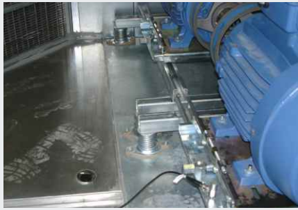
Lagerung von riemengetriebenen Ventilatoren
