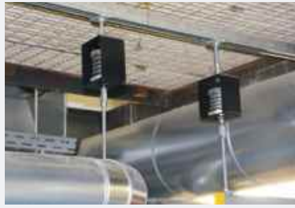
Entkoppelte Rohrleitungen mit Isotop® SD/Z
