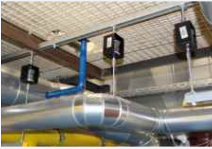
Aufhängung Rohrleitung mit Isotop® SD/Z
