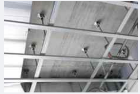
Deckenabhängiger Isotop® MSN/Z-LC
