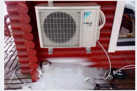
Außeneinheit einer Wärmepumpe auf Wandhalterung
