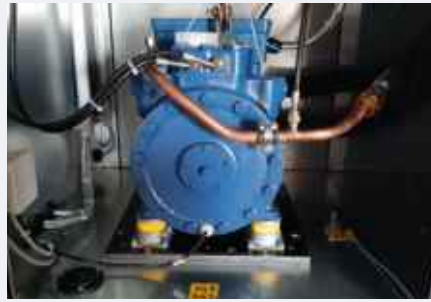
Lagerung eines Hubkolbenkompressors mit Isotop® DZE Mini
