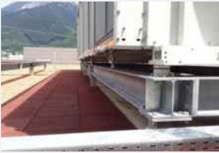
Rückkühler mit Isotop® DZE gegen hohe Windlasten
